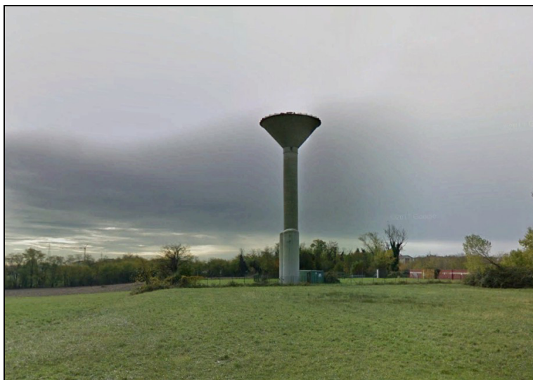
Figura 2. La torre piezometrica in via delle Industrie
